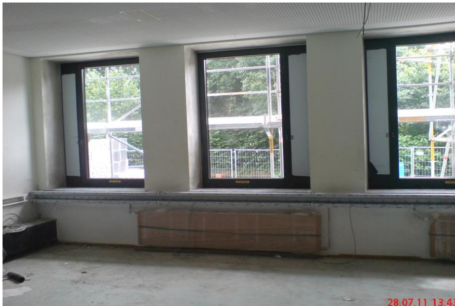
Fenster mit senkrechten Lüftungsöffnungen
